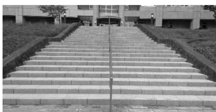
外階段 (改修後)
