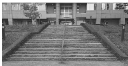
外階段 (改修前)
