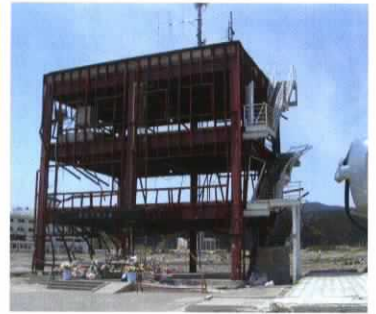
「震災のシンボル：防災庁舎跡」 (ここで町職員他42名殉職) (平成24年5月14日)
