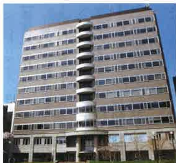
川内キャンパスの教育学部棟 (最寄駅 地下鉄東西線「川内駅」)
