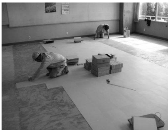
パネル貼り替えの様子(同校 HP より)
