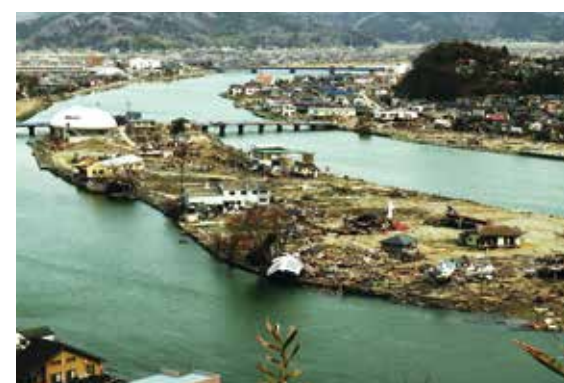
平成23年3月20日 石巻市中瀬公園
