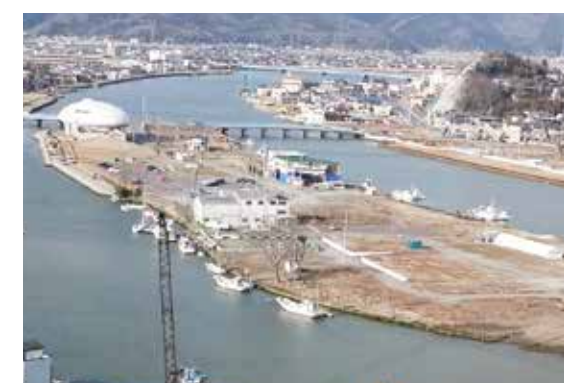
平成25年3月20日 石巻市中瀬公園
