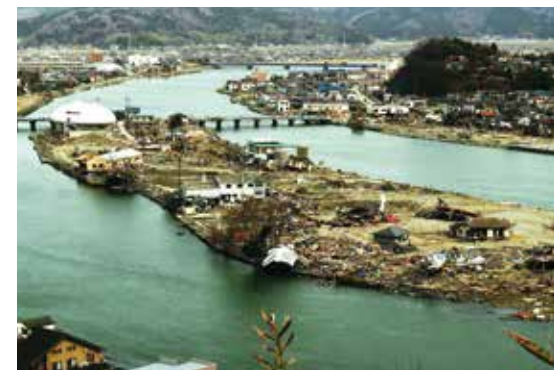
平成23年3月20日 石巻市中瀬公園
