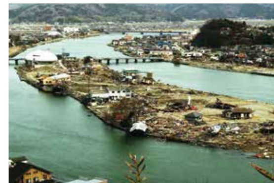
平成23年3月20日 石巻市中瀬公園
